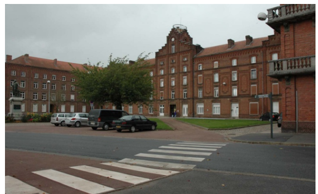
写真3 ファミリステール外観
