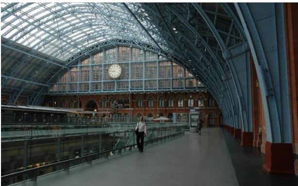
写真 10 セントパンクラス駅（内観）
