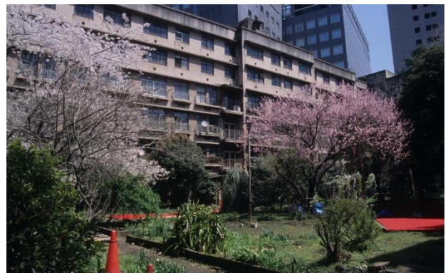
写真 20 同潤会アパートメント
