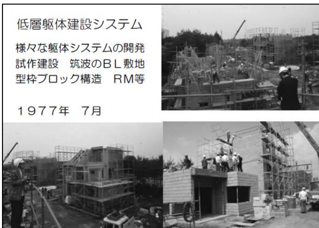
図 13 低層躯体建設システム
