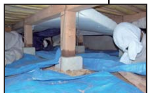
床に断熱材を入れる
