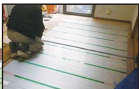
床暖房の設置
