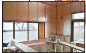
壁に断熱材を入れる
