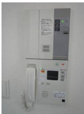
【緊急通報装置】
