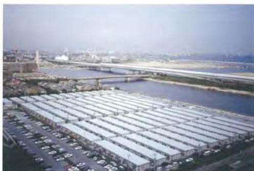
芦屋市南部の埋立地に建てられた仮設住宅
