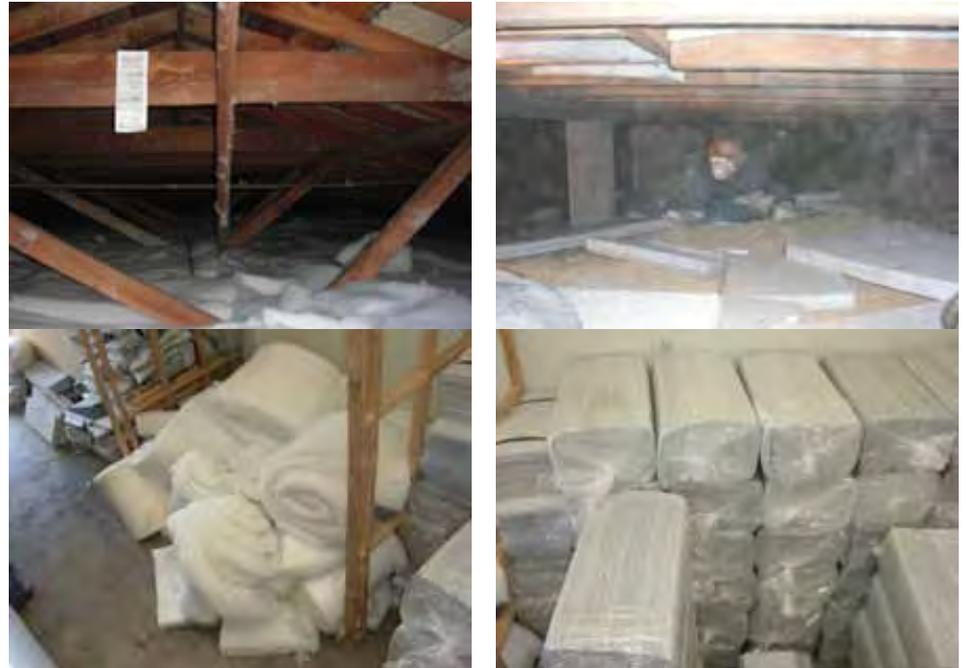
改修で用いた断熱材と改修風景
