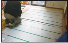
床暖房の設置
