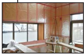
壁に断熱材を入れる
