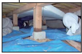
床に断熱材を入れる
