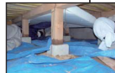
床に断熱材を入れる
