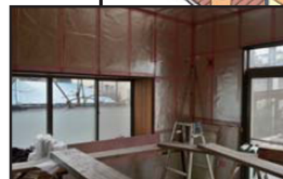
壁に断熱材を入れる
