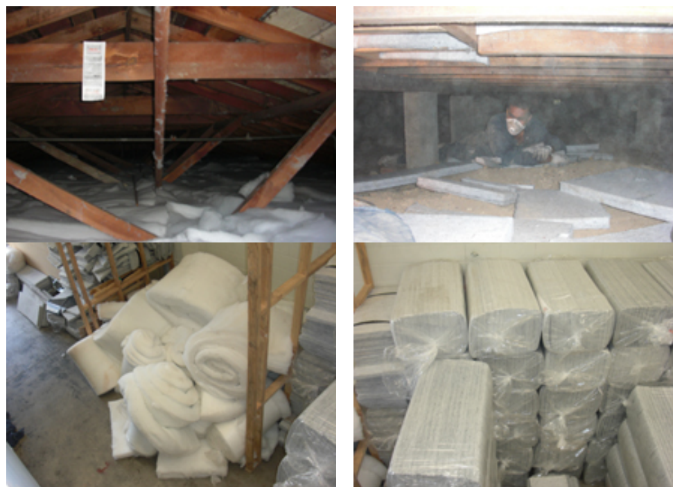
改修で用いた断熱材と改修風景
