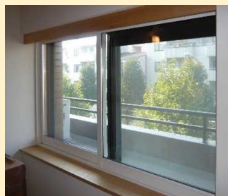
既存アルミサッシに樹脂の内窓を設置
