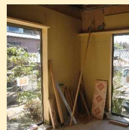
壁に内張断熱材を設置
