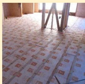
断熱材を根太間充填
