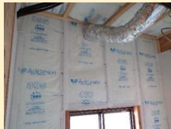
図 6-2 外壁は高性能グラスウールを充填
