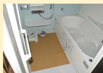
浴室ユニットに入れ替え
