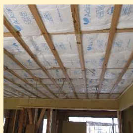
天井に断熱材を充填
