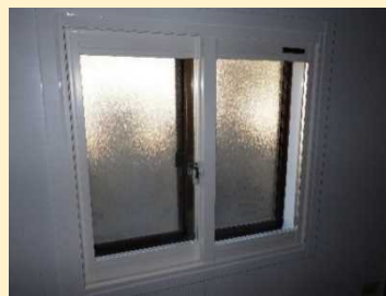
図 6-4 樹脂製複層ガラス 内窓設置
