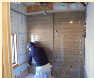
断熱した上で浴室ユニットに交換
