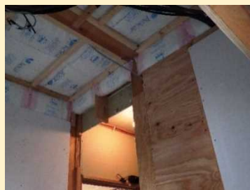
図 6-3 天井も高性能グラスウールを敷き込み
