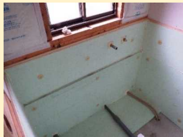
図 6-1 基礎に押出法ポリスチレンフォーム施工
