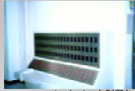
(エレベータ制御台)
