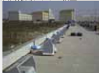
共用排気ダクトの検査
