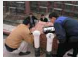
キッチン排気ダクト検査
