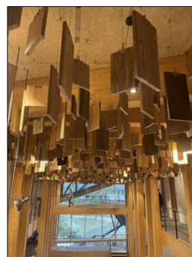
吹き抜け空間上部に吸音材として設置した木材
