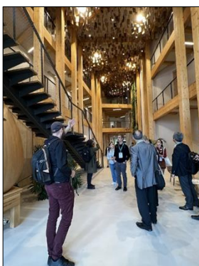
吹き抜け空間上部に吸音材として設置した木材
