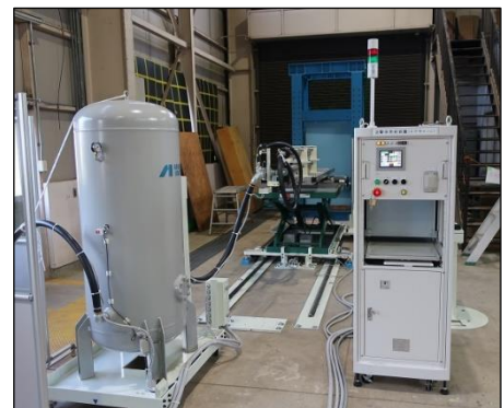
写真2 エアタンク・制御盤
