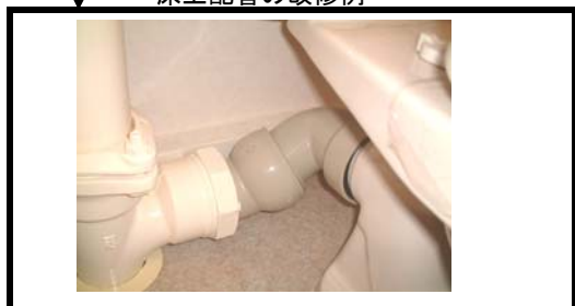
床上配管の改修例
