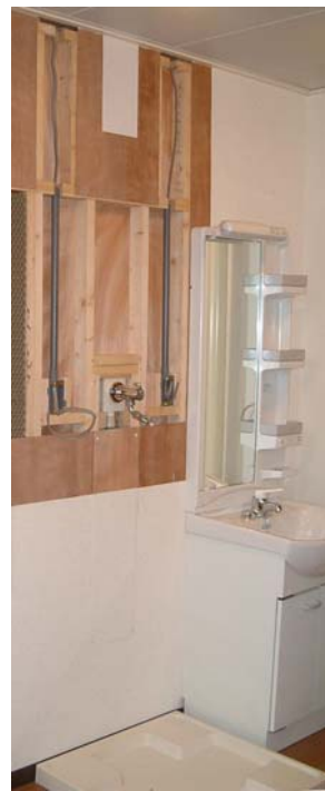
配管組込用内装壁ユニット (説明用に下地を露出表現)
