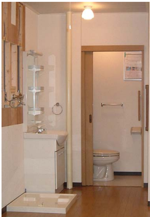
トイレ・洗面所スペース拡大キット設置例 (一部, 説明用に下地を露出表現)
