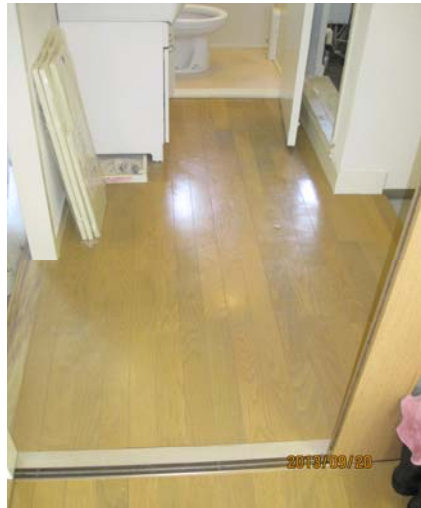
④給水・給湯配管の壁貫通部分
