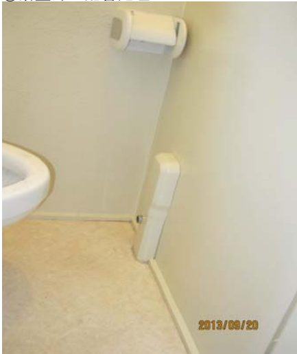
③浴室外の配管処理
