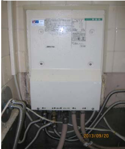
①浴室内部機器設置正面
