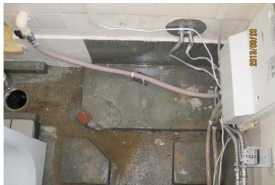
⑥浴室側配管、電線の施工
