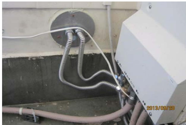
②給水・給湯配管の屋内壁貫通部分
