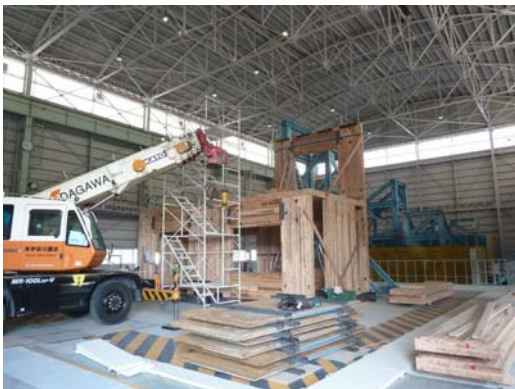
写真 1 試験体施工状況
