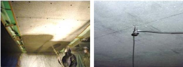
写真 1 PCM 吹付け状況 写真 2 ワイヤー巻付け状況
