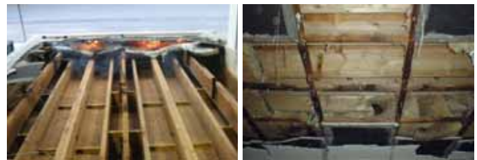
試験体 No.1 試験後
