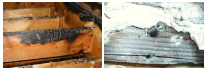
試験体 No.1 試験後
