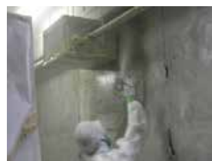
3. 飛散抑制剤の吹付け
