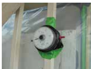
2. 作業室の負圧確認
