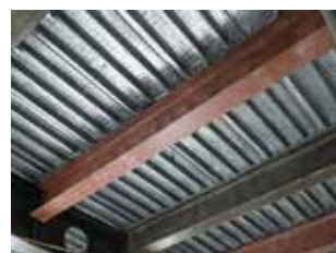
6. 除去作業完了
