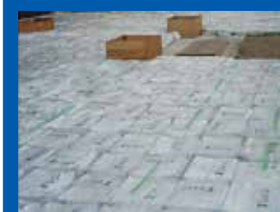
⑪土間部完成
