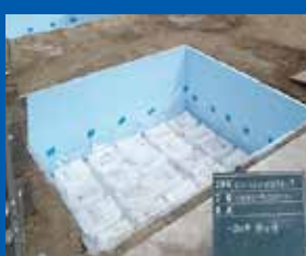
⑥基礎部完了
