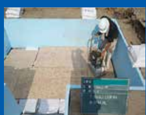
④基礎部転圧
