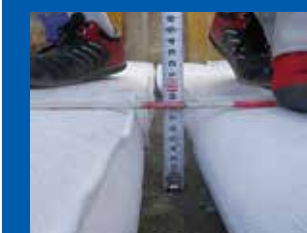
⑤基礎部高さ測定
