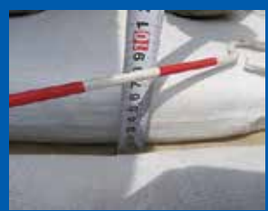
⑩土間部高さ測定
