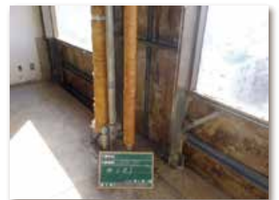
6. 除去作業完了
