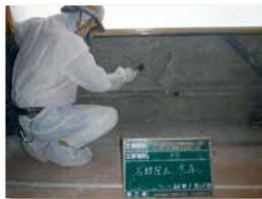
5. 除去作業状況
