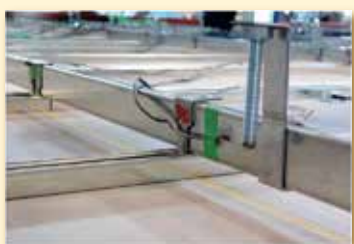
被害なし：耐震クリップの状態
