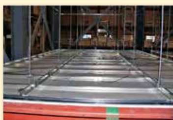
被害なし：クリップ外れなし
