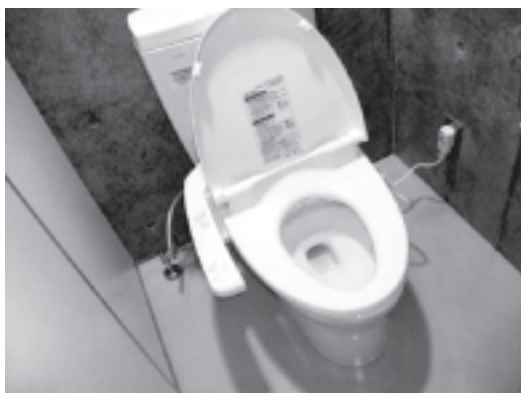
写真5 トイレの便器設置状況
