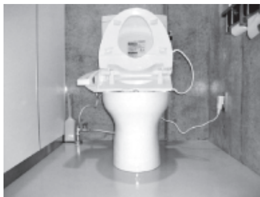
写真6 トイレの便器設置状況
