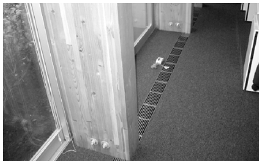
写真5 床スリット吹出し口
