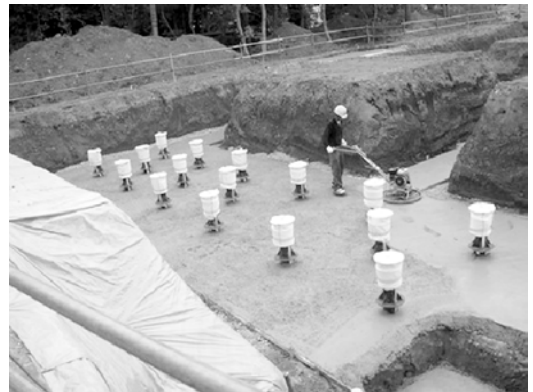
写真2 鋼管杭施工直後(南側)
