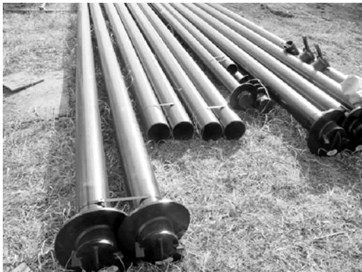
写真1 設置した鋼管杭
