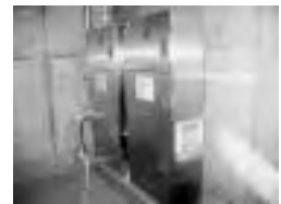
写真3 熱交換用水槽と熱交換器
