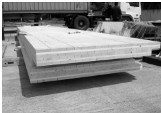
写真1 クロスラミナパネル(床パネル厚さ142mm)
