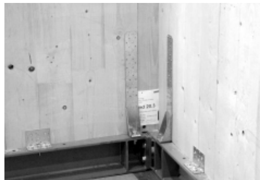
写真5 パネル端部の金物固定
