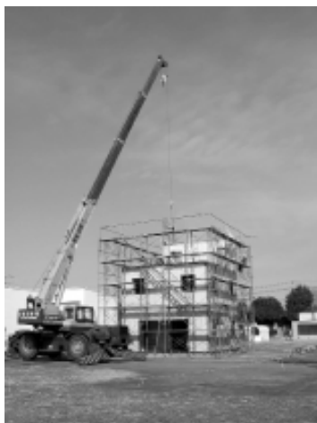
写真3 XLamシステムでの建物建設状況 (火災実験建設時 Phase Cの建物を移築)
