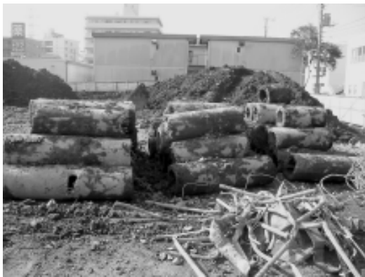
写真2 解体現場で廃材となる既製杭の杭頭部分など
