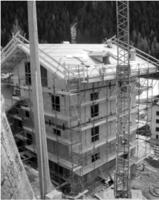
写真11 XLamでの木造建築事例( RASOM社提供 )
