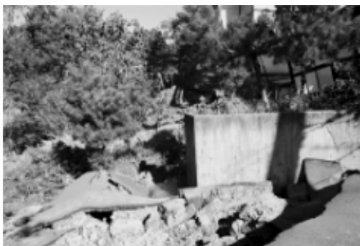
写真1 緩斜面住宅地の被害(新潟中越地震)
