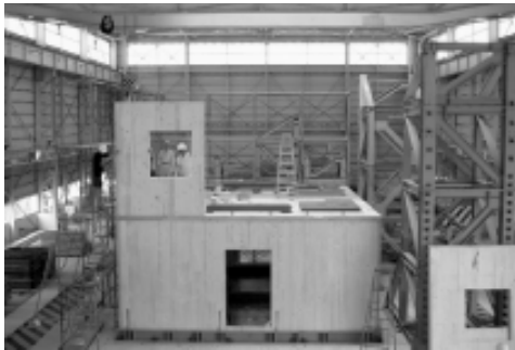
写真6 鉄板おもりを用いた積載荷重(Phase A)
