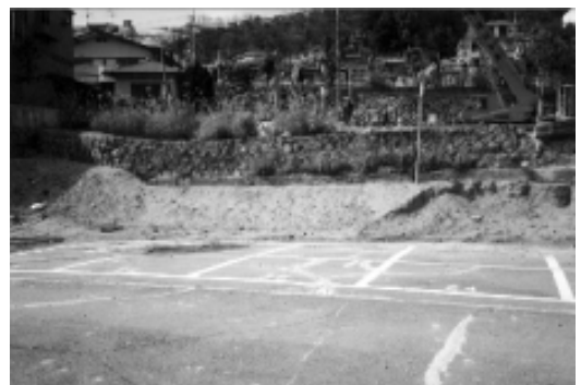
写真3 宅地の変状と復旧工事(兵庫県南部地震)
