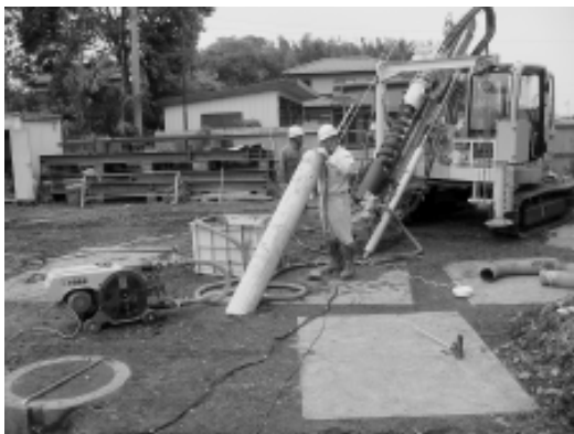
写真4 調査用保護ケーシングでの調査状況
