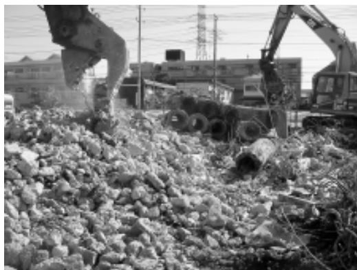
写真1 解体現場の状況
