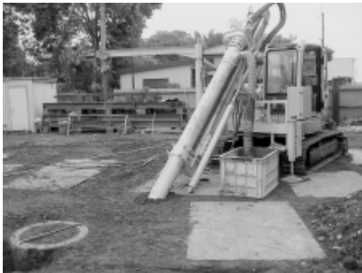
写真3 開発した既存杭調査機械の掘削状況
