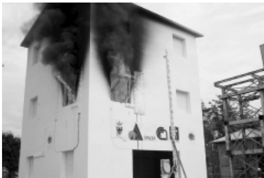
写真9 実大火災実験試験体 (2階南西側1室から出火と設定 45分経過時)
