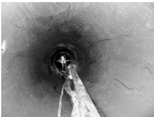
写真5 保護ケーシング内部の調査機器設置状況
