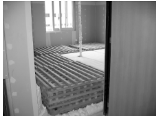
写真10 火災室可燃物設置状況 (ドア開口には、日本製防火ドア(60分)を設置)
