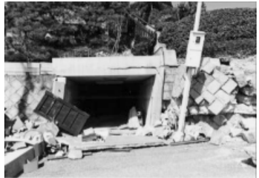
写真2 宅地の変状(兵庫県南部地震)
