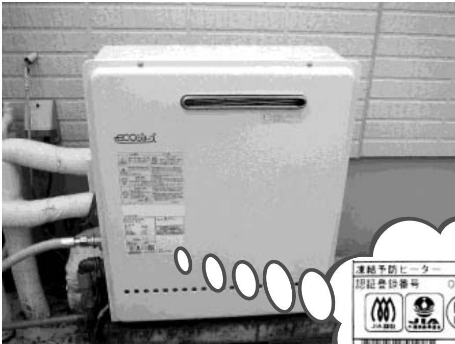
給湯機設置状況
