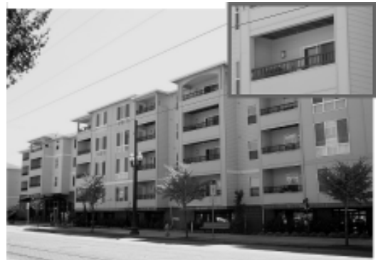
写真3 木造集合住宅(1層RC、2～5層枠組壁工法)
