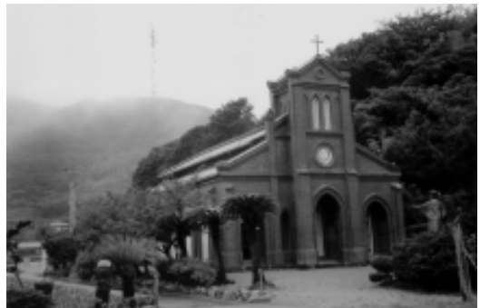
写真1 堂崎教会外観
