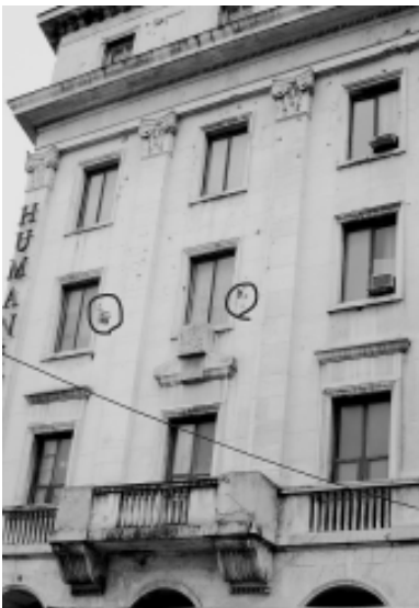
写真4 旧共産党本部前の建物外壁。子細に観察すると弾痕が数多く残っているのが発見出来る(丸印の所)。
