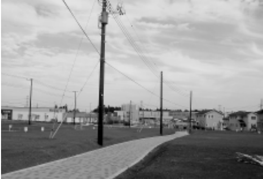
写真4 造成地における電柱
