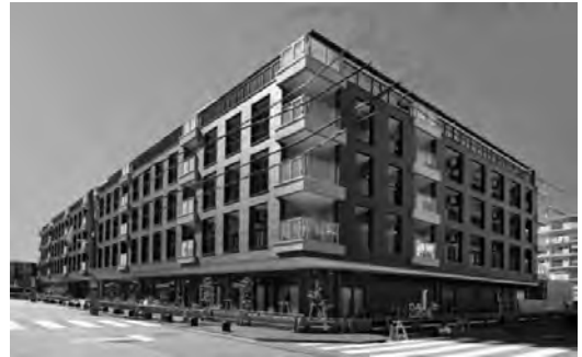
写真 3 MPW 耐力壁を用いた特別養護老人ホーム (三井ホームホームページより引用)
