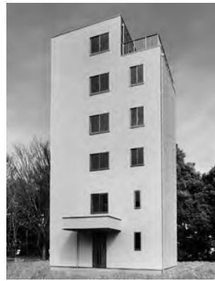
写真7 6階建枠組壁工法建築物の実験棟
