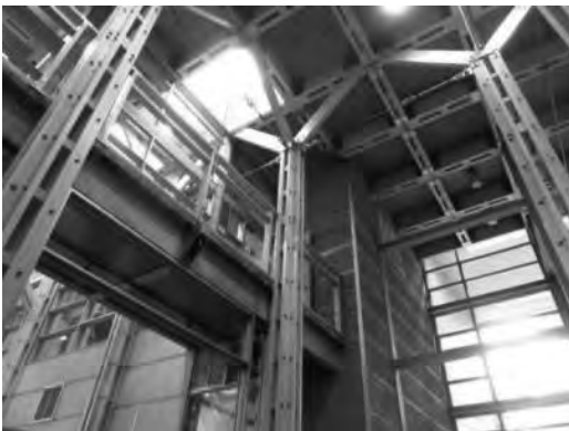
写真9 FP Innovations Lab建物内部の構造フレーム
