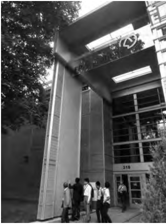
写真8 FP Innovations Labの入り口に設置されているCLTパネル
