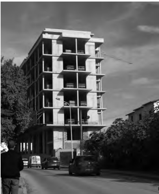
写真8 建設中の建物
