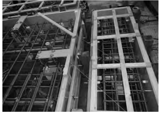
写真6-b) 底版配筋工事
