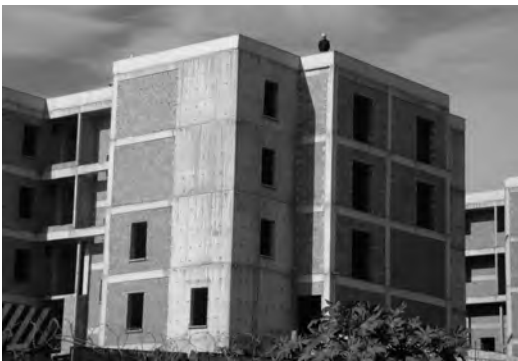
写真7 建設中の建物
