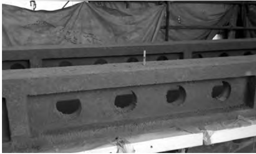
写真2 S造梁試験体の一例(耐火被覆)
