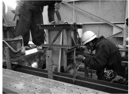
写真4-d) コンクリート打込み状況
