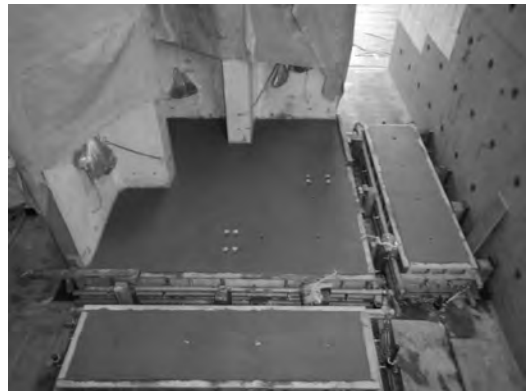
写真6-d) 底版コンクリート表面金罫仕上げ
