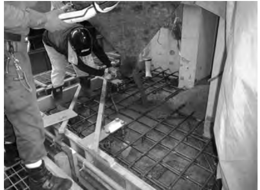
写真6-c) 底版コンクリート打込み
