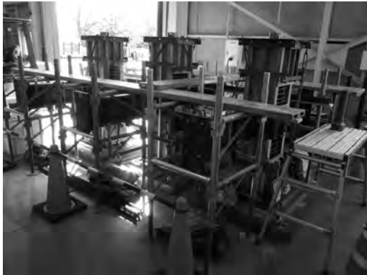
写真4-b) 型枠工事
