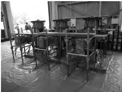
写真4-c) コンクリート打込み準備
