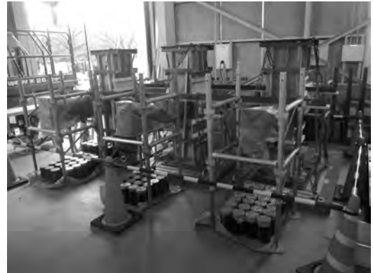
写真4-e) コンクリート打込み後の養生
