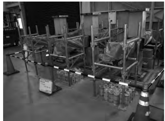
写真4-f) 型枠脱型工事後の養生
