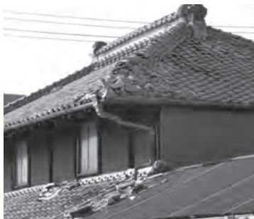
写真10 寄棟屋根 瓦状況詳細
