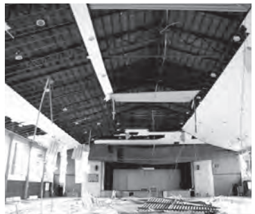
写真9 体育館の天井材落下
