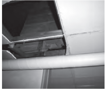
写真6 天井を突破りブロック落下
