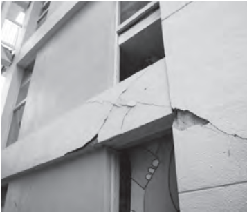
写真4 短スパン梁のせん断破壊
