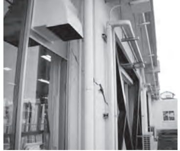
写真3 補強ブレース周辺柱のせん断破壊
