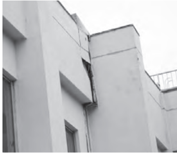
写真5 Exp.Jの衝突による損傷
