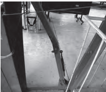
写真7 ラチス柱の斜材の座屈
