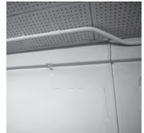
写真12 ブロック目地部に沿ったひび割れ
