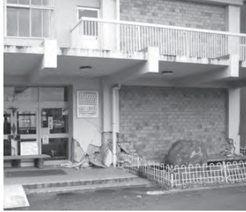
写真2 連層耐震壁脚部の圧壊
