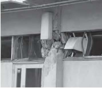
写真1 極短柱のせん断破壊
