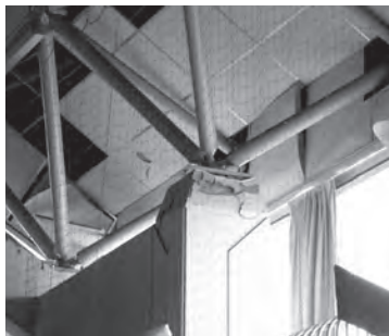
写真8 RC-S接合部の掻出破壊
