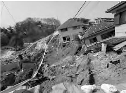
写真1 地盤の滑動崩落により被害を受けた住宅
