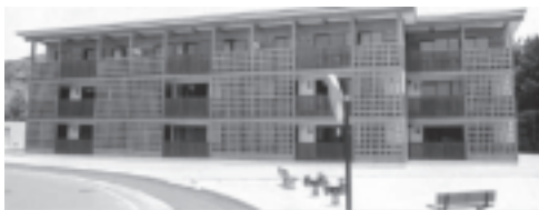
写真6 建物外観(準耐火建築物)
