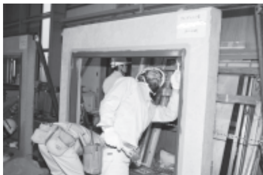
写真6 カバー工法(防錆処理)
