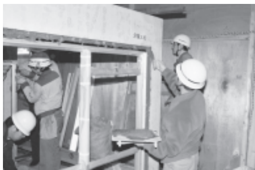
写真4 引き抜き工法(モルタル充填)
