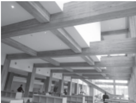
写真4 建物内部の様子
