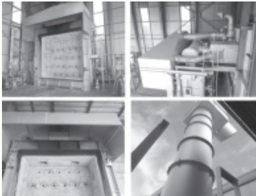
写真1 炉全景及び二次燃焼炉
