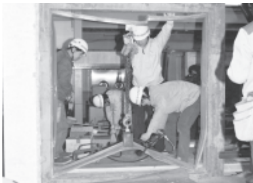
写真2 引き抜き試工法(既存サッシの撤去)
