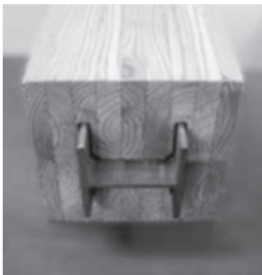
写真5 柱部材断面
