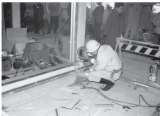
写真3 引き抜き工法(サッシの建て込み)
