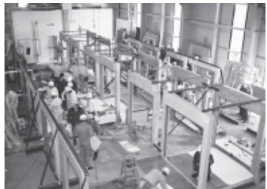
写真1 施工試験(全景)
