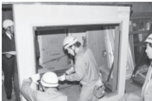
写真7 カバー工法(枠の取り付け)
