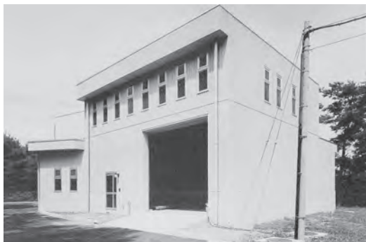
写真2 音響試験棟はコンクリートの塊
