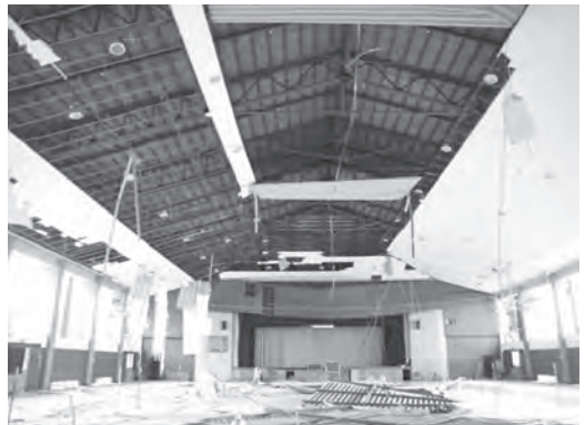
写真6 屋内運動場天井の落下
