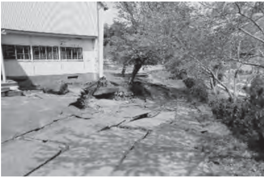
写真9 斜面崩壊隣接建物の基礎杭露出
