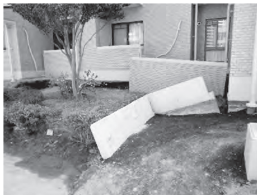
写真1 液状化現象(噴砂と塀の傾斜)
