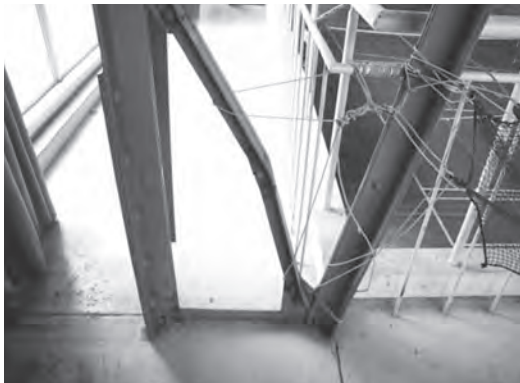
写真5 屋内運動場ラチス柱材の座屈
