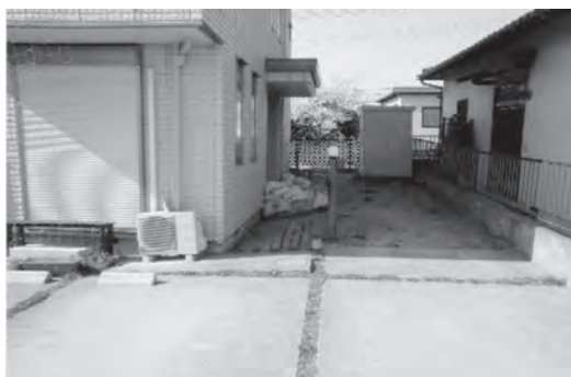
写真3 住宅周辺地盤沈下と建物傾斜
