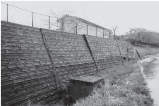
写真11 擁壁の変状と建物の関係
