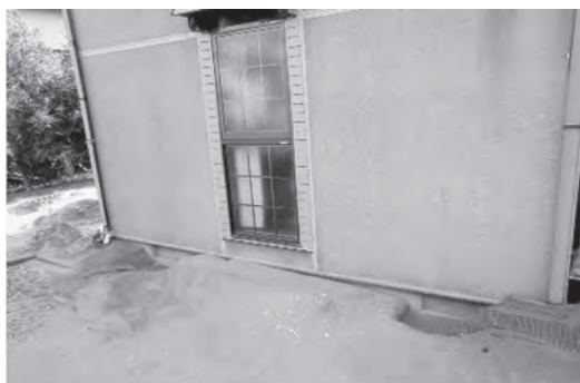
写真5 建物周辺の噴砂（建物沈下）
