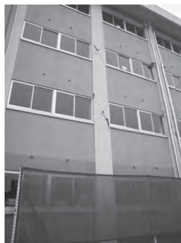
写真2 柱に損傷を受けた校舎
