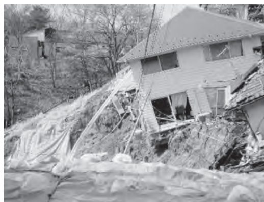
写真2 斜面崩壊(建物の損壊)
