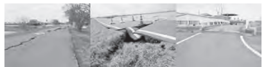
霞ヶ浦サイクリングコースの損傷状況写真 (茨城県サイクリング協会HPより引用)
