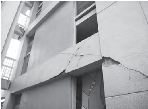
写真3 短スパン梁のせん断破壊
