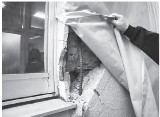
写真4 2次壁の被害
