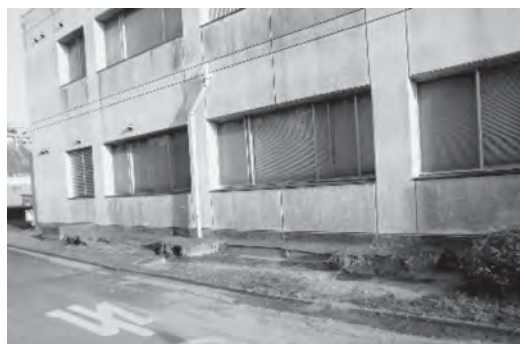
写真6 建物周辺地盤沈下（杭基礎）
