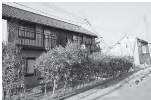
写真4 電柱の傾斜と建物一部損壊
