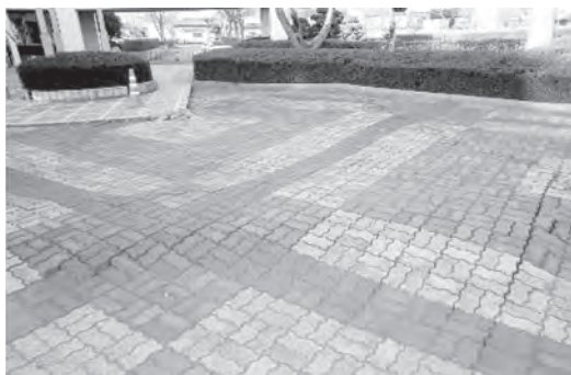
写真7 建物周辺仕上げ面の変状
