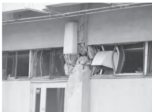
写真1 せん断破壊した極短柱
