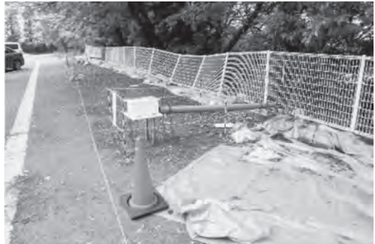
写真12 斜面崩壊(計測)と塀の傾斜
