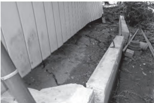
写真13 地盤変状に伴う基礎の損傷
