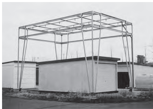
写真3 物置ユニットの雨水試験
