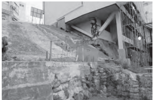
写真14 斜面地擁壁と建物基礎の状況
