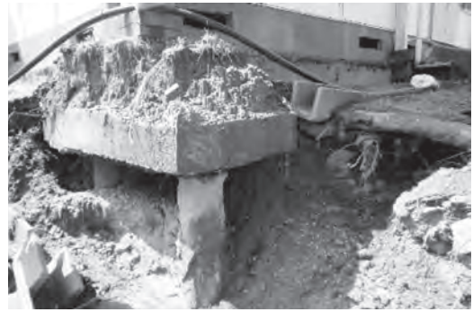
写真10 基礎杭の露出状況(写真9)
