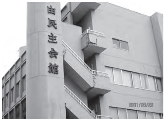
写真7 屋外階段と本体接合部の被害
