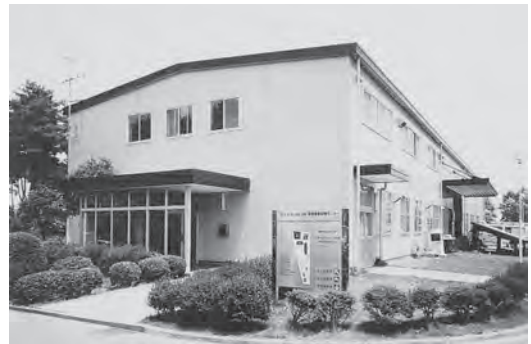
写真1 第一試験棟の増築直後
