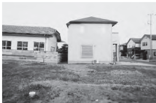
写真8 噴砂痕と建物の傾斜
