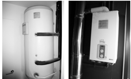
各住戸の貯湯タンクとバックアップボイラー
