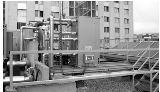
矢崎総業製の吸収式冷凍機と集熱パネル
