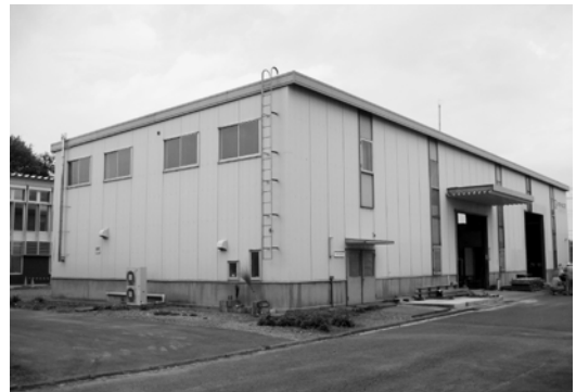
写真1 製作ヤード外観
