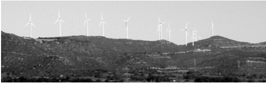
山の尾根伝いに設置された風力発電施設
