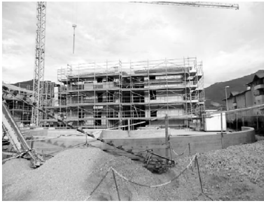
写真6 CLTを用いた3階建集合住宅
