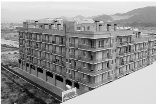
太陽熱利用システムが設置されている集合住宅
