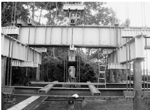
写真3 載荷桁設置例
