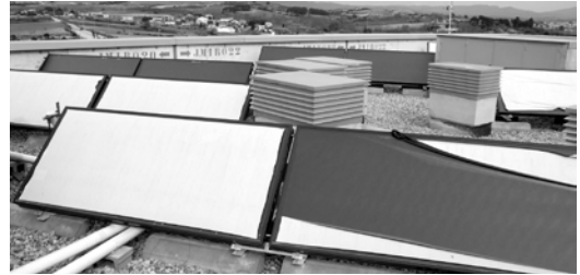
屋上の集熱パネル
