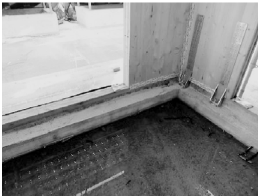
写真8 ホールドダウン金物での基礎とCLTの接続
