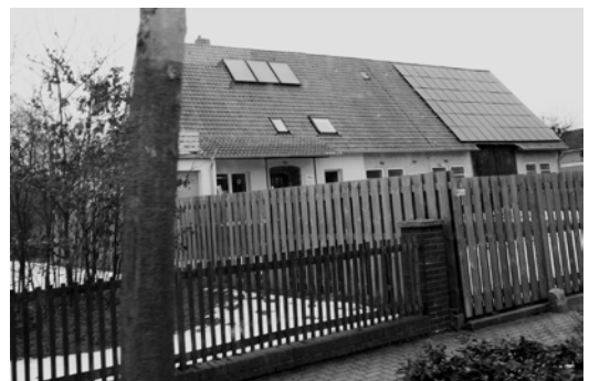
ドイツ郊外の住宅の太陽熱利用システム + PV + 天窓
