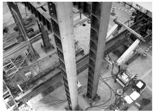
写真1 キャリブレーション試験状況(試験棟内)
