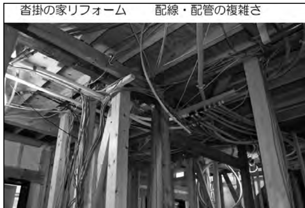
図13 天井裏の配線・配管
