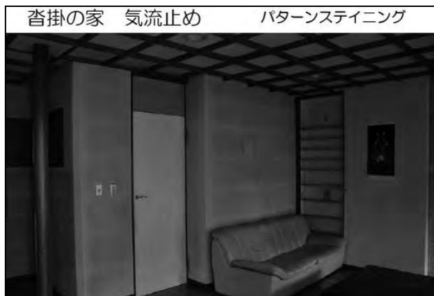
図11 杓掛の家 リフォーム前の間仕切り壁
