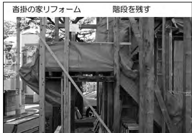
図8 沓掛の家リフォーム 解体工事中 (階段)
