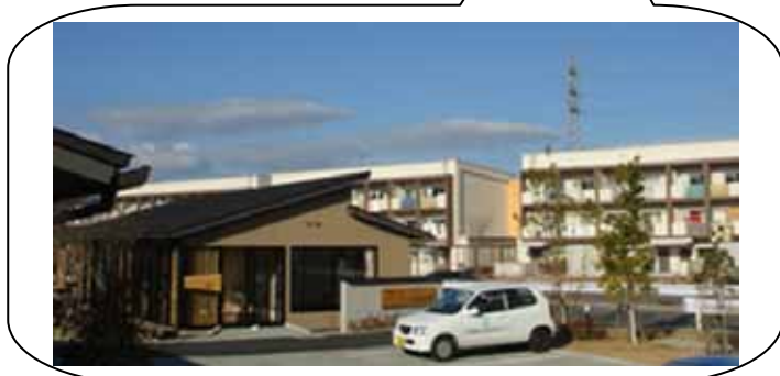
南橋団地の地域交流施設。後 方は原の前団地
