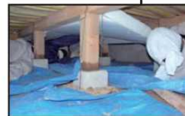
床に断熱材を入れる
