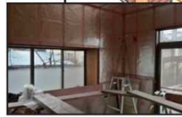
壁に断熱材を入れる
