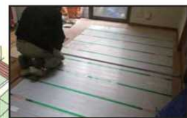
床暖房の設置
