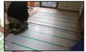
床暖房の設置
