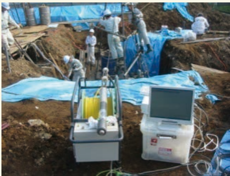
既存杭利用のための調査状況
