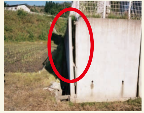
調査により傾きが確認された擁壁
