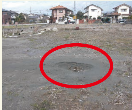
調査により確認された 液状化による噴砂痕
